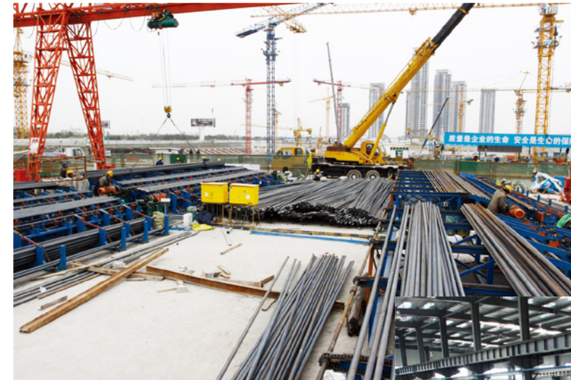
天津117大厦钢筋加工中心 Tianjin 117 Mansion
