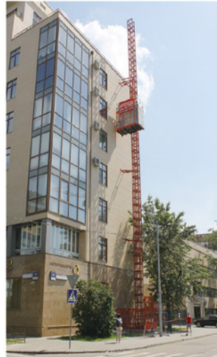
凯博施工升降机在俄罗斯 Building hoist in Russia
