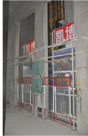
天津嘉里中心240米井道施工升降机 Tianjin Kerry Center, installed in Elevator Shaft (240m)
