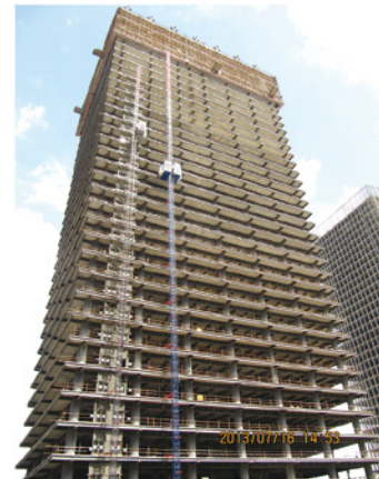
天津于家铺升龙金融中心240米SC200/200 变频调速施工升降机 SC200/200 (VVVF, H=240m) in Tianjin Shenglong Financial Center
