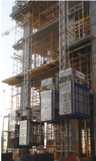
沙特吉达项目施工升降机 Saudi Arabia Jeddah project, building hoist
