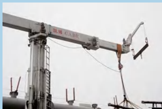
擦窗机设备在吊装横向摩天轮器材
